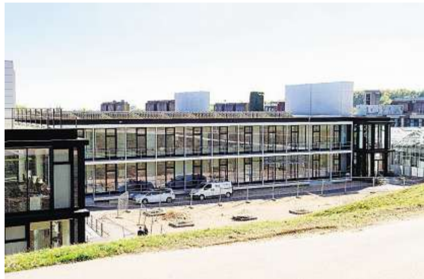
Die Ingenieurbüro Brundobler GmbH war für sämtliche M-Technik-Gewerke beim Bau des Ausweichgebäudes Naturwissenschaften West der Universität Regensburg verantwortlich. Fotos: Ingenieurbüro Brundobler/Pieknik
