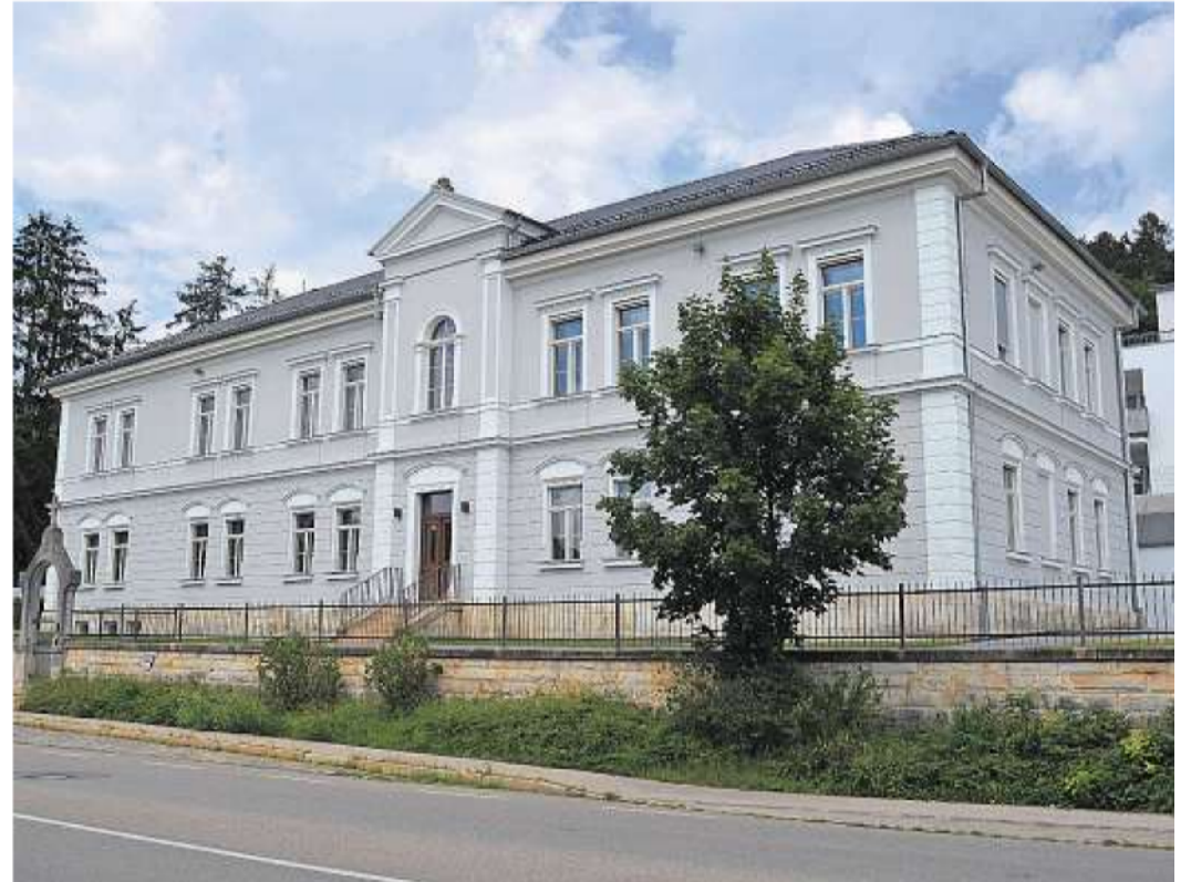
Ein Firmensitz mit Stil: das sanierte ehemalige Kelheimer Krankenhaus
