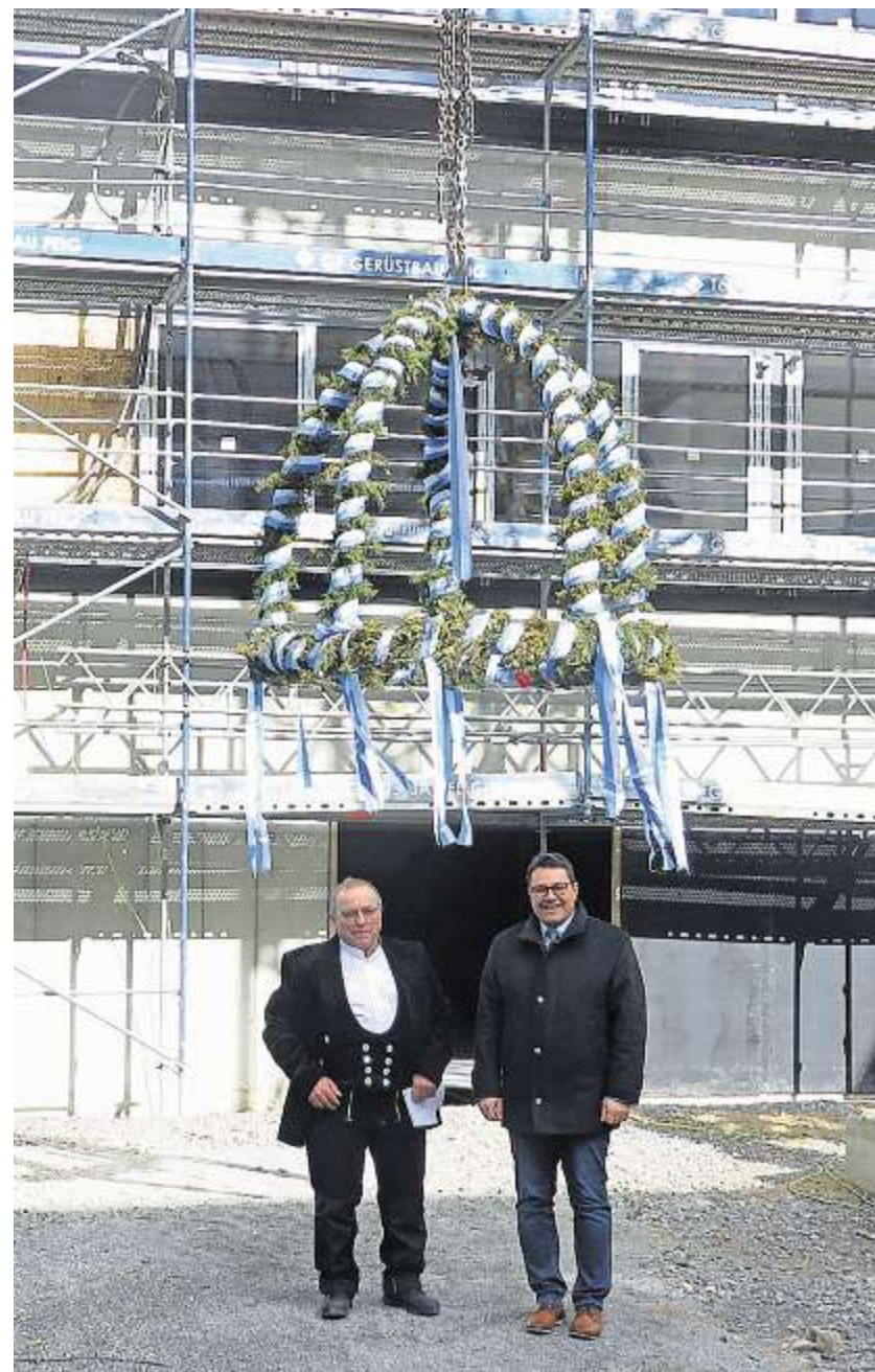
Unter der Richtkrone hieß der Wackersdorfer Bürgermeister Thomas Falter (r.) die Gäste willkommen. Zimmermeister Rudi Piendl sagte den Richtspruch auf.
