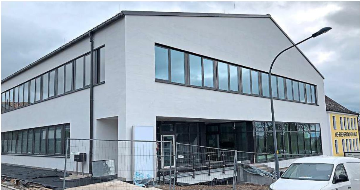
Das neue Gebäude neben dem Mehrgenerationenhaus steht kurz vor der Fertigstellung.
