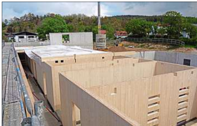
Blick auf die Baustelle: Langsam wächst die neue Dreifachsporthalle in Regenstau die Höhe. Foto: Max Häusler, Landratsamt
